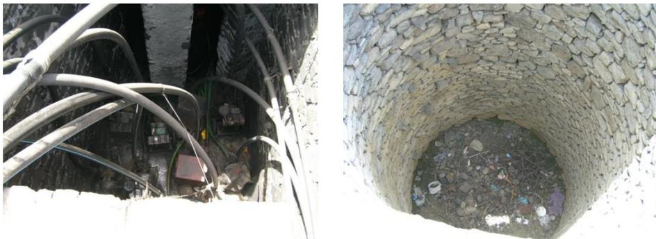
Figura 4 – Bombeamento intensivo nos poços artesanais vs consequência (Pina, 2005).
